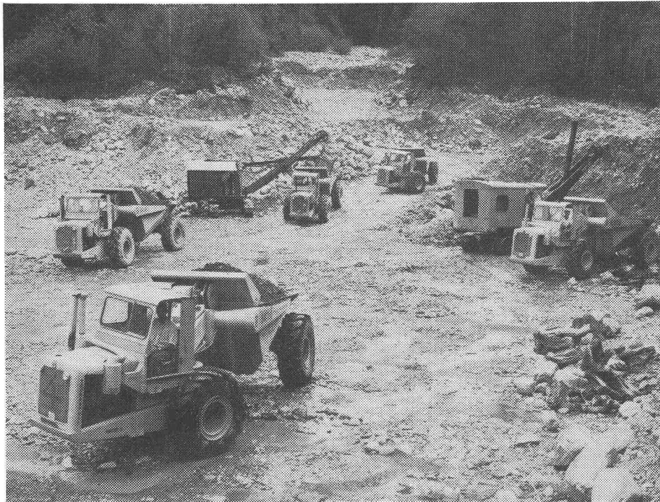
Kiesgewinnung für den Koffer einer Flugpiste
