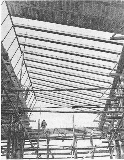
Bild 2. Montage der frei gespannten Deckenkonstruktion aus Fertig-Elementen in «Stahlton»
