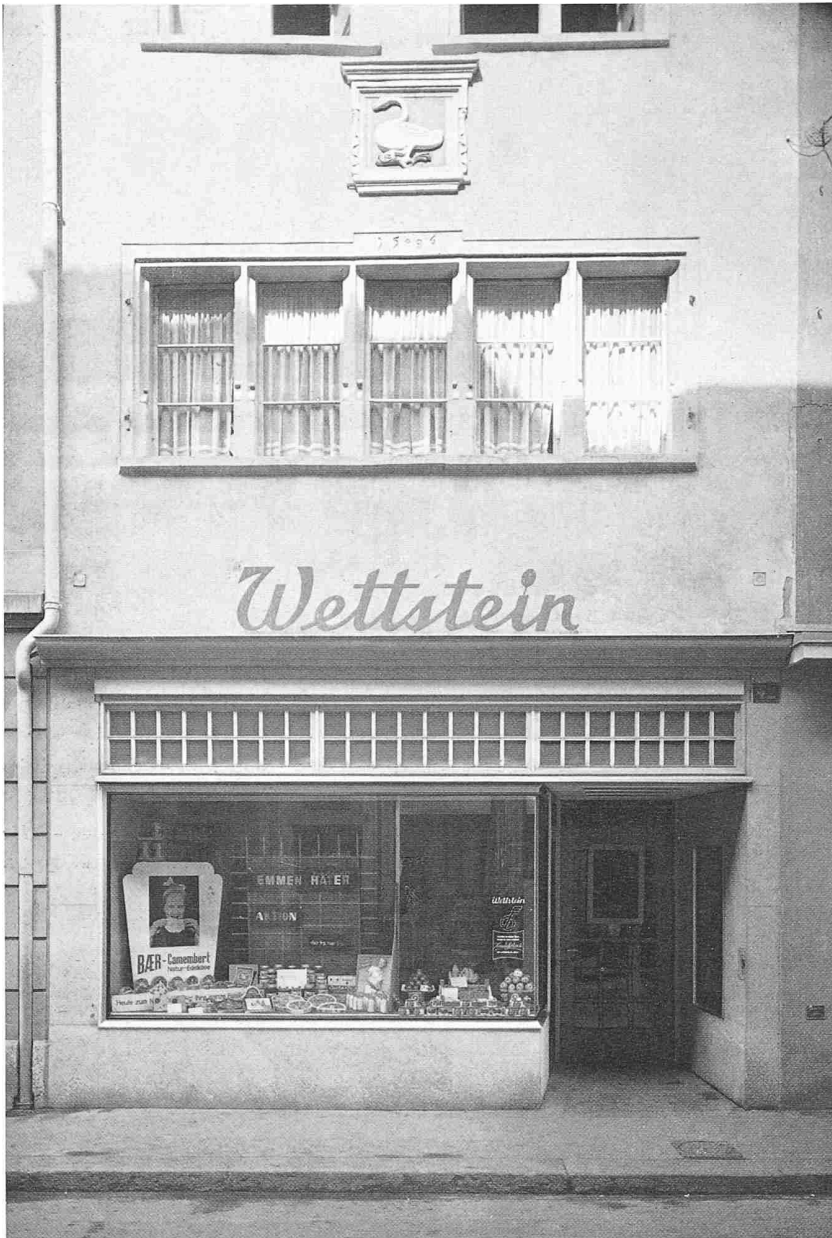
Ladenstrasse. Vorbildliche Lösung; die Massstabreduktion des Oberlichtstreifens lässt die Fenster im ersten Stock wieder «gross» erscheinen, während sie ohne dieses Zwischenglied «klein» wirken würden. Arch. Franz Scheibler, Winterthur.
