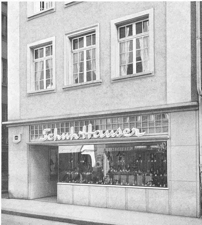
Ladenstrasse. Eckhaus. An der Ecke ist ein massiver Pfeiler nötig; die etwas massive Schrift liegt in der richtigen Höhe und ist deshalb für das Strassenbild unschädlich. Arch. R. Spoerli, Winterthur.
