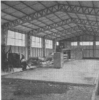
Die neue Fabrikhalle der Int. Verbandstoff-Fabrik Neuhausen a. Rheinfahl
