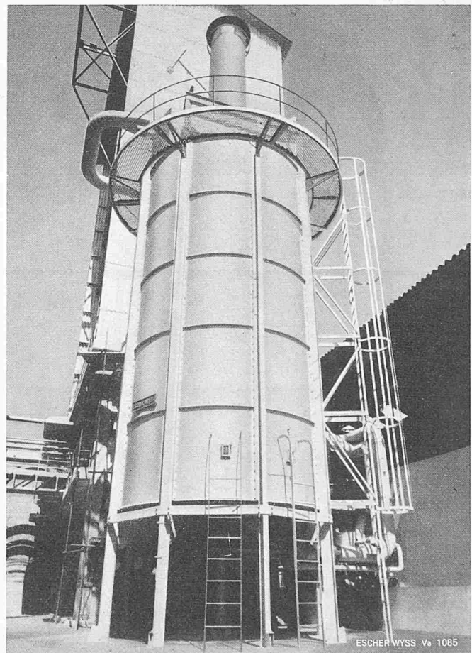
Bild 11. Escher-Wyss-Dowthermerhitzer mit Zwangsumlauf, separater Verdampfertrommel und zentraler, vertikaler Brennkammer
