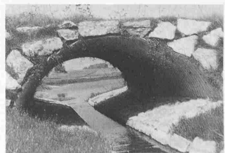
Hochwasserrückhaltebecken Chefikon. Durchsicht aufs Becken mit Brücke über dem Einlauf
