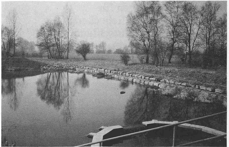
Fischbach bei Niederglatt/Neerach. Beispiel eines Hochwasserrückhaltebeckens mit einseitiger Überflutungszone (Neeracher Ried), kombiniert mit Hechtteich
