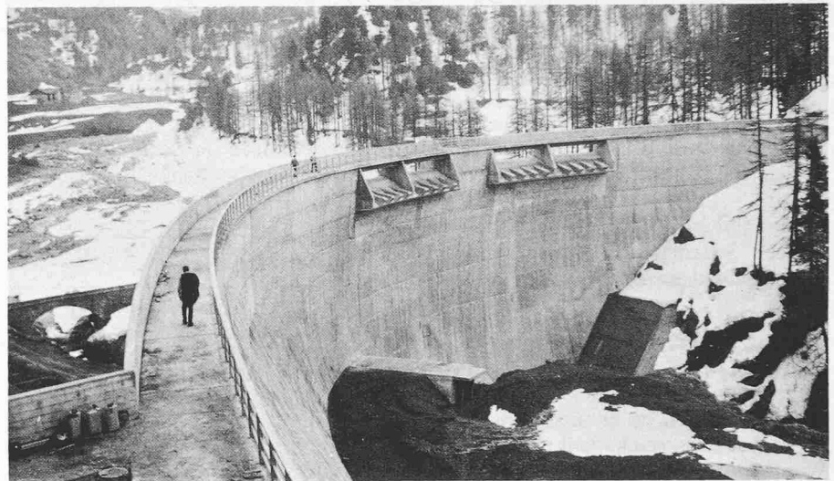
Staumauer Orden an der Orlegna im Bergell (GR). Ansicht von der Luftseite
