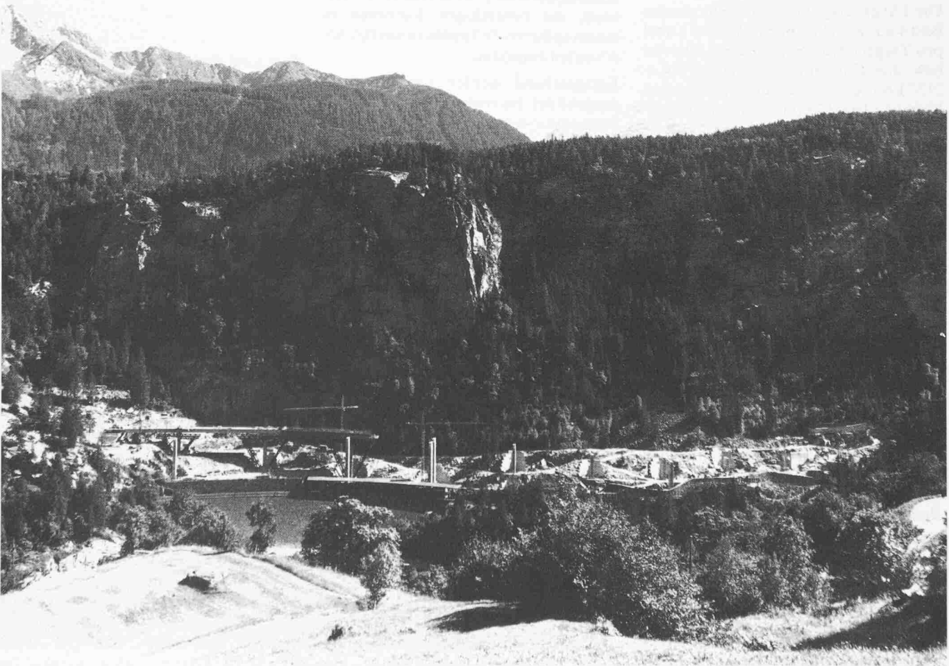
Bild 14. Stand der Arbeiten am 23. Juli 1980
