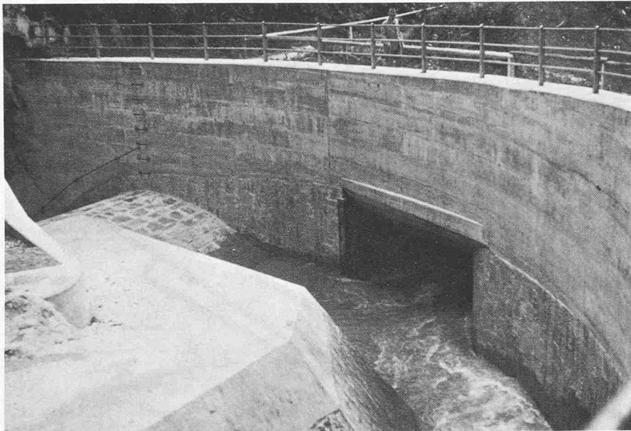
Bild 11. Verzweigungsbauwerk des Fexbachs (GR). Es handelt sich um ein Bauwerk der Variante A in Bild 3. Bei Niedrigwasser durchquert der gesamte Zufluss sowie das Geschiebe die Öffnung in der Sperre. Bei zunehmender Wassermenge fliesst das Überschusswasser ( Q_2 ) sowie ein Geschiebeanteil von etwa 75% über die in den Stollen führende Schwelle
