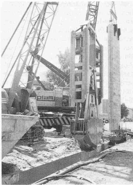
Bild 2. Schlitzaushub und Versetzen eines vorgefertigten Wandelements
