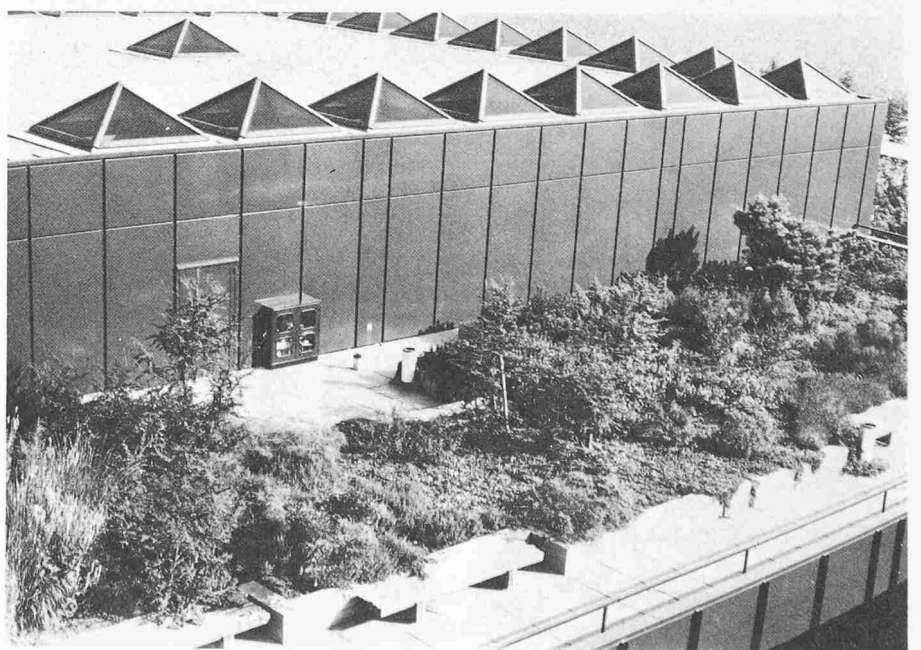
Bild 2. Teil des Dachgartens, Steuerschrank an der Bibliotheksfassade
