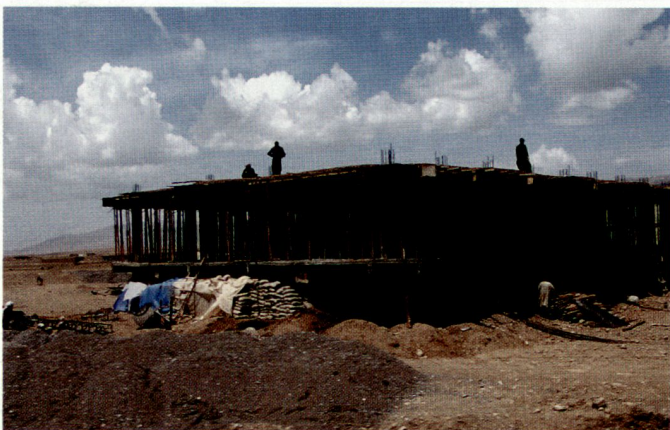
Häuserbau in der Provinz Loghar.
