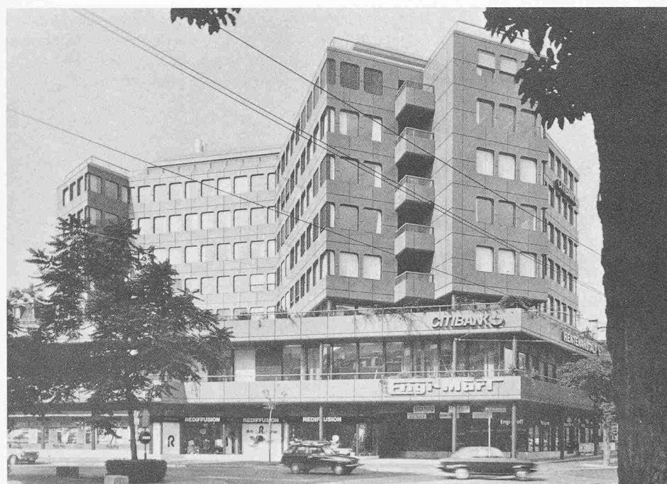
Ostansicht, links Lavaterstrasse, rechts General Wille-Strasse
