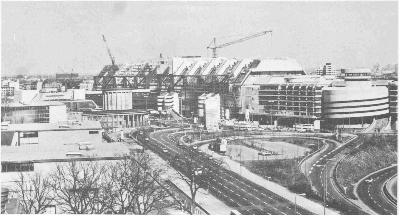
Blick von Südwesten, rechts das Parkhaus mit der Auffahrtsrampe
