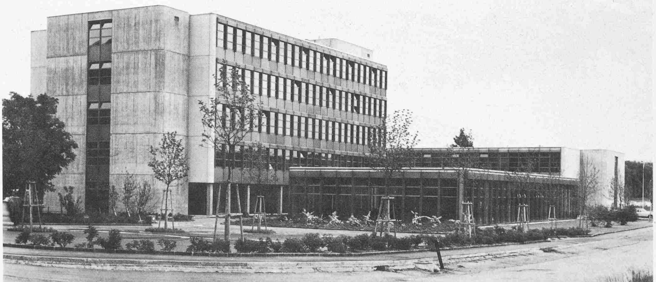
Ansicht von Südosten, rechts die Mensa, links die Schule, hinten das Werkstattgebäude
