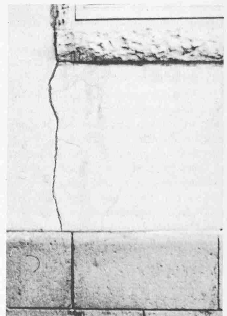
Bild 5. Thermische Risse
