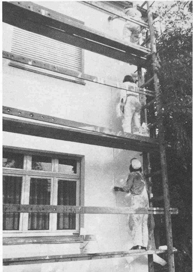
Bild 6. Einlegen des Elastic-Gewebes in den Armierungskleber
