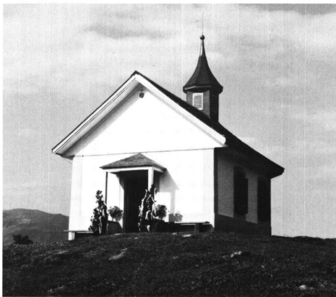
Abbildung 29 Illgau, Herz-Jesu-Kapelle im Hinteren Oberberg. Das Äussere nach der Restaurierung mit dem in seiner Grösse reduzierten Vorzeichen.
