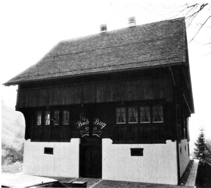
Abbildung 41 Freienbach, Pfäffikon, Buchberg. Die Eingangsfront nach der Restaurierung mit dem Erbauungsdatum 1783.
