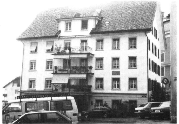
Abbildung 37 Einsiedeln, Haus Adam und Eva. Die barocke Fassade wurde im späten 19. Jahrhundert umgestaltet. Aus dieser Zeit stammt auch der Balkonvorbau.
