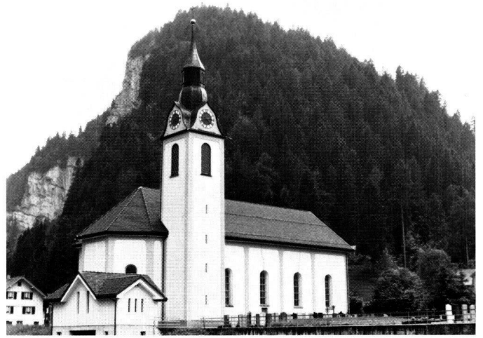
Abbildung 22 Unteriberg, Pfarrkirche St. Joseph. Choransicht, in den 60er-Jahren wurden die aufgemörtelten Fassadengliederungen und die reich profilierte Dachuntersicht entfernt.
