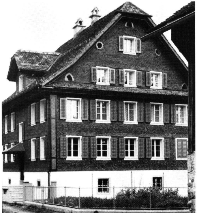
Abbildung 14 Arth, Haus Ehrli. Hauptfront nach der Restaurierung.
