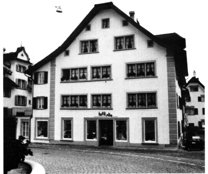
Abbildung 6 Schwyz, Haus Gürber, ehemals Apotheke Triner. Hauptfront nach der Restaurierung mit rekonstruierter Eckquaderbemalung.
