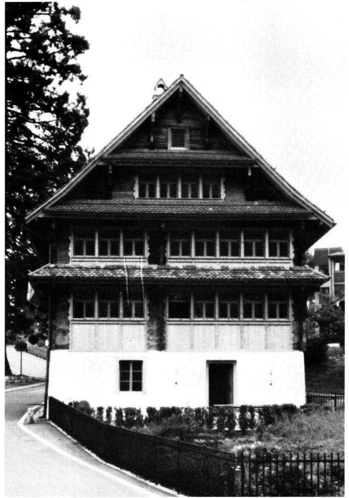
Abbildung 26 Morschach, Pfarrhaus. Die Hauptfront mit der wiederhergestellten alten Fenstereinteilung und den Ziehladenverkleidungen.
