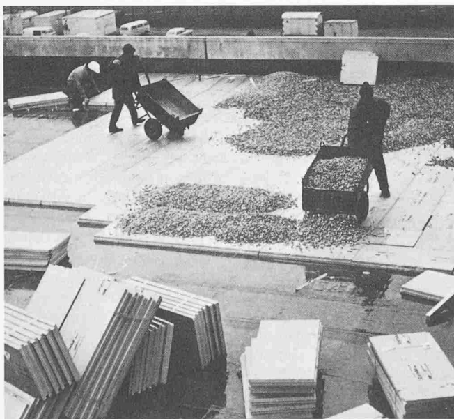
Aufbringen der Styrodurplatten und Bekiesung
