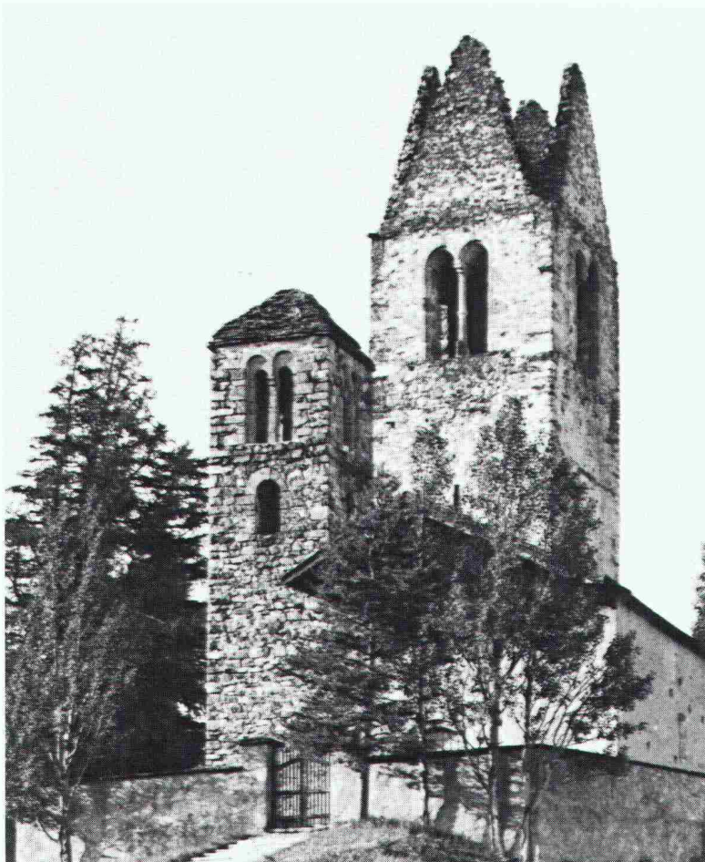
San Gian Celerina: statische Verbesserung der Turmdecke und Abdichtung gegen eindringen- des Wasser.
