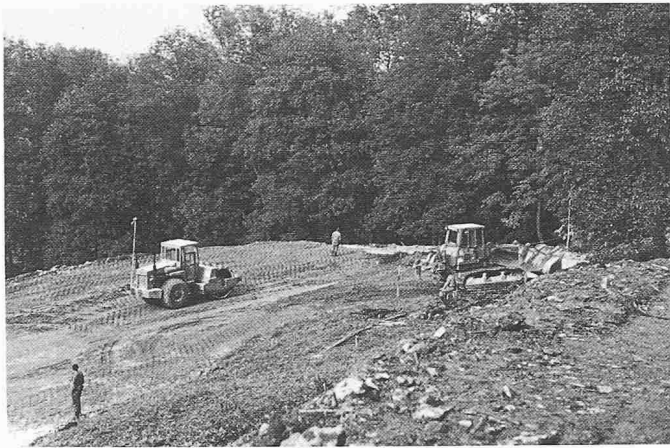
Bild 5. Schütтарbeiten in einer Wendeplatte
