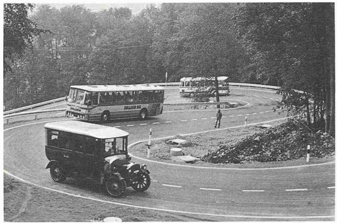
Bild 6. Fertiggestellte Notstrasse anlässlich der Verkehrsübergabe
