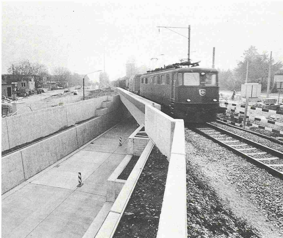
Bild 6. Unterführung als wasserdichte Wanne in Sperrbeton mit Betondeckbelag. Eisenbahnbrücke 20° schief mit Trogform. Comet Bild
