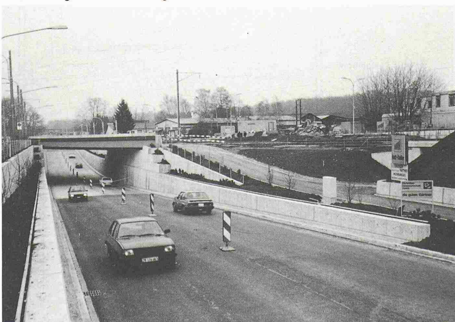
Bild 7. Unterführung im Betrieb. Am Bildrand rechts die separate Rad- und Fusswegunterführung. Foto D. J. Bänziger 13. 12. 86
