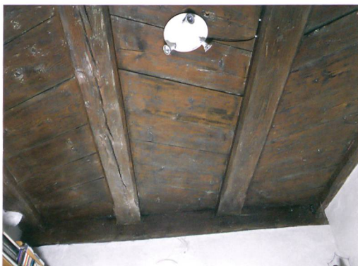
Abb. 5: Ligerz, Chlyne Twann 7. Zweites Obergeschoss. Die Decke im östlichen Saal wurde mit fischgrätfförmig eingeschobenen Bohlen gebaut; die einzelnen Hölzer verfügen über eine Strichzier. Blick nach Nordwesten.
