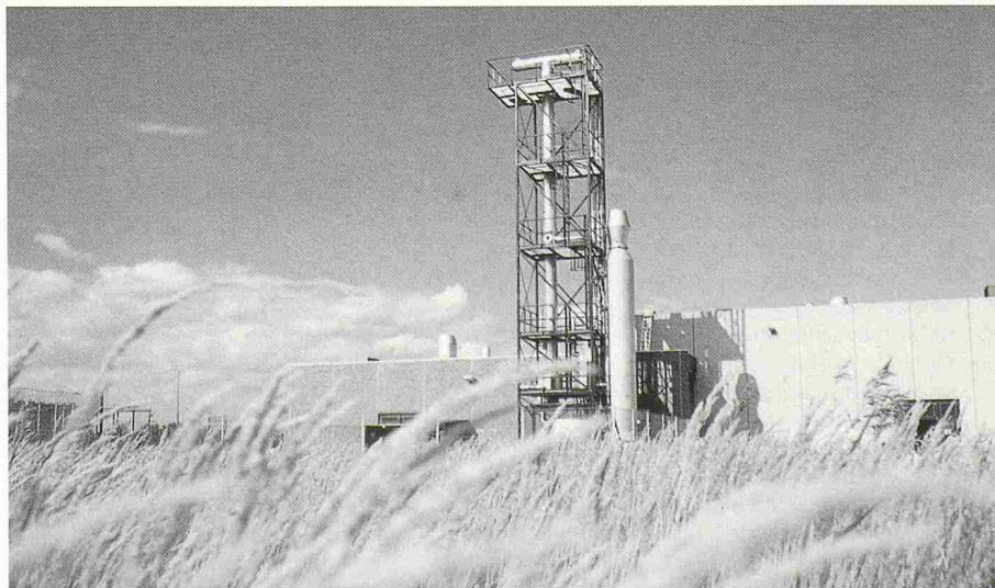
Bild 1. Isopropanolrückgewinnungsanlage für einen Pharmabetrieb
