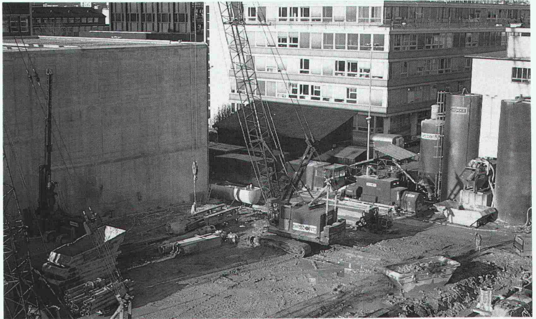
Flur Süd, Zürich. SBG-Neubau Energiezentrale
