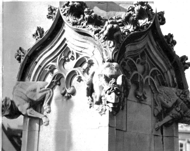
Zierwerk an einem Pfeiler
