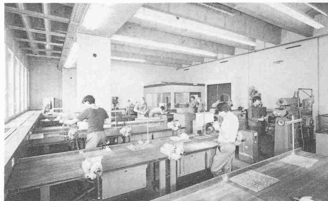
Lehrlingswerkstatt im 1. Obergeschoss. Die Kanäle der Lüftungsanlage sind in der vorfabrizierten Betonkonstruktion integriert
