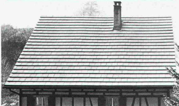
Der BRAAS-REDLAND-FLACHZIEGEL RF ergibt eine ebene, ruhige, die Horizontale betonende Dachfläche. Die Deckbreite des Normalziegels ist 30 cm, die Lattenweite ist variabel bis max. 34 cm. Dies ermöglicht ein problemloses Umdecken ohne neue Lattung.
