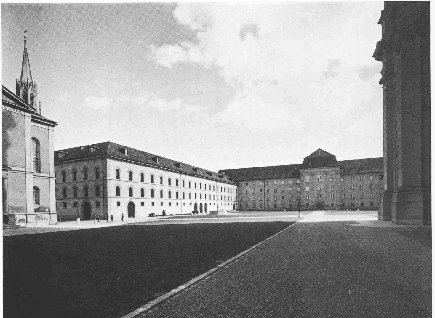
Der restaurierte Zeughausflügel von Südwesten. Vorne links der Eingang des Kantonsgerichtes und der Verwaltung, in der Mitte der Eingang zu den Archiven und der Bibliothek
