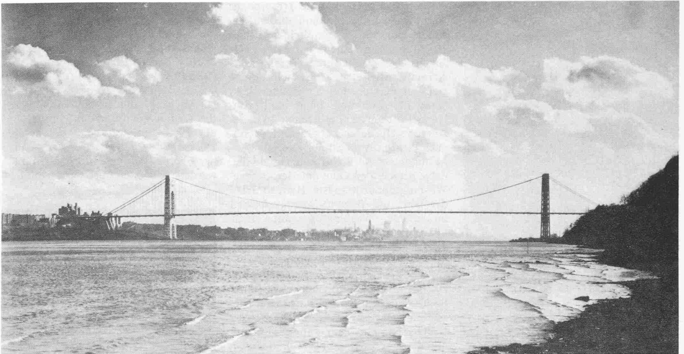
Bild 9. George Washington Bridge mit oberem Deck, 24. Oktober 1931 eröffnet
