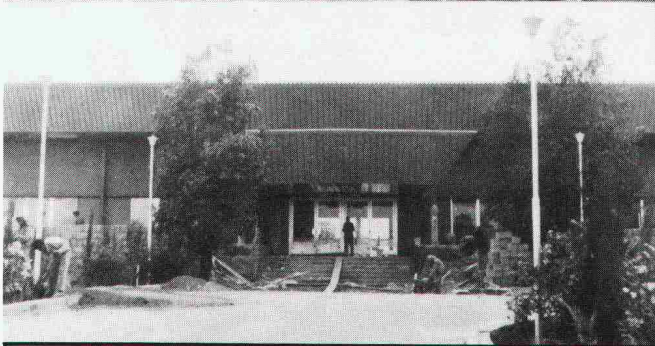
Empfangshalle Khamis Mushayt, Empfangshalle Tabuk, Saudi-Arabien
