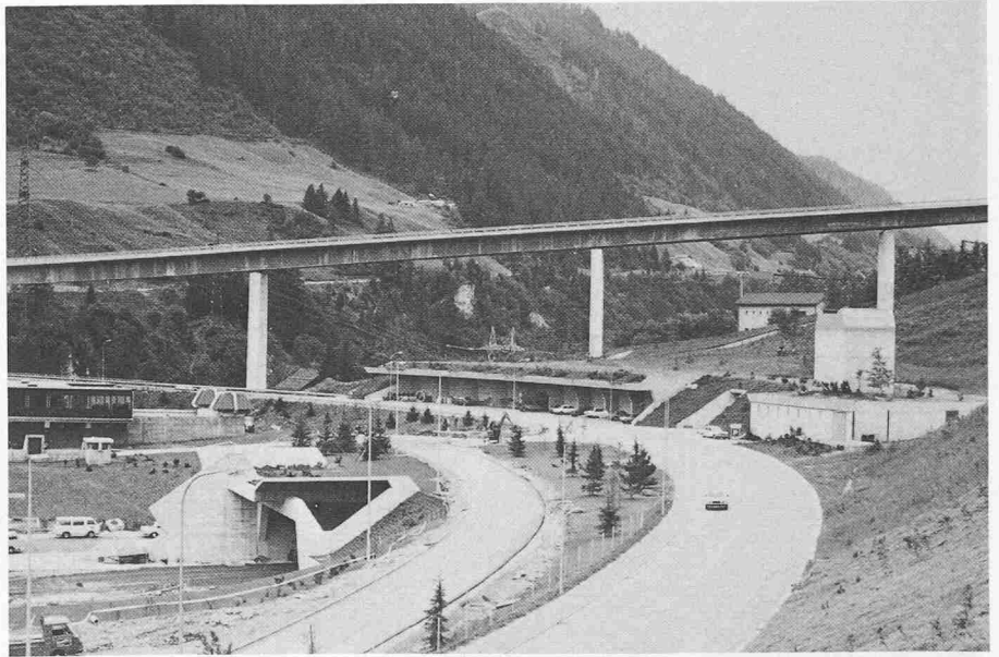
Bild 11. Blickrichtung quer zur Nationalstrasse Richtung Westen, mit dem Portal Airolo (links im Bild, dahinter ein Teil des Betriebsgebäudes) und in Bildmitte, bergseits der neu angelegten Verbindungsstrasse Richtung Bedrettotal, die von aussen sichtbaren Teile der Lüftungszentrale Airolo. Das Frischluftfassungsbauwerk beschreibt einen langgezogenen Bogen, während sich die eigentliche Lüftungszentrale mit dem Abluftkamin, die über der Tunnelröhre liegt, sich rechts im Bilde befindet
