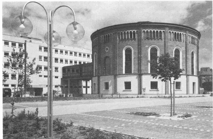
Der restaurierte Gasbehälter mit der Verbindung zum Gebäude der Stadtwerke
