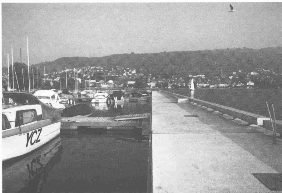
Hafenanlage in Zug, Mole 4 m breit
