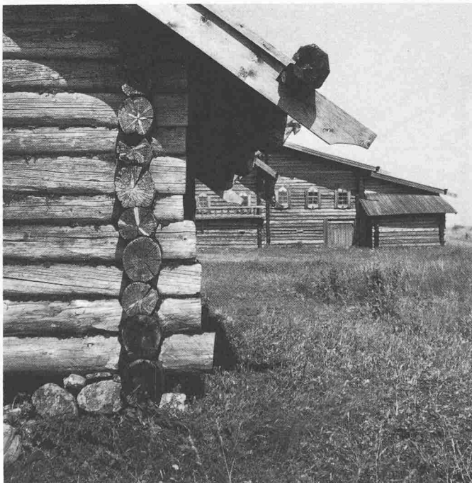
Ecklösung einer einfachen Scheune und im Hintergrund das Jelisarow-Haus, 1880 n. Chr.
