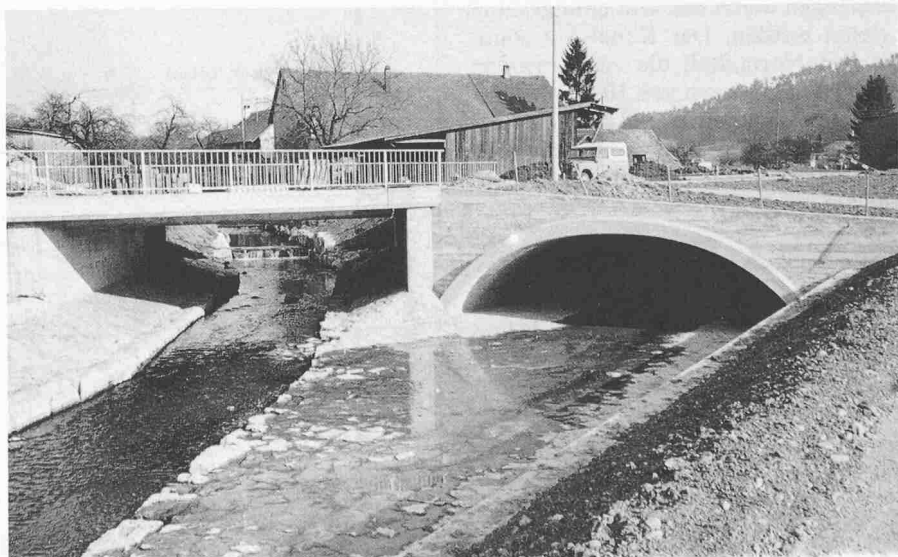
Bild 7. Vereinigungsbauwerk. Links: Bestehendes Eulachgerinne. Rechts: Auslauf der Hochwassereindolung
