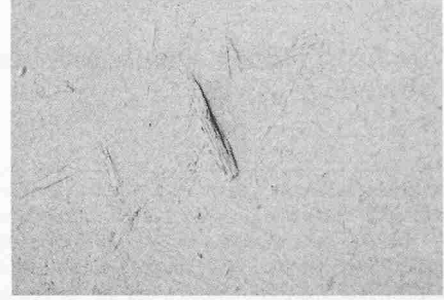
Bild 4. Nahaufnahme der Oberfläche einer Fassadenplatte aus «Durisol-CB»-Platten (Pavillonanbau Spital Baden/[Schweiz])
