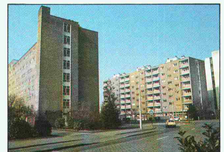
▲ Belgien : Sozialer Wohnungsbau, Gent. (Sanierung)
