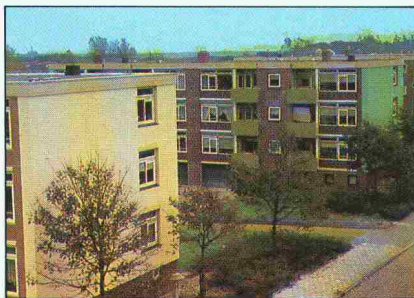
▲ Niederlande : Sanierung von Wohnhäusern, Den Helder.
