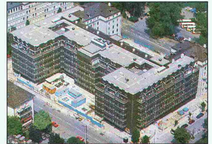
▲ Schweiz : Verwaltungsgebäude, Mythen-schloß, Zürich.
