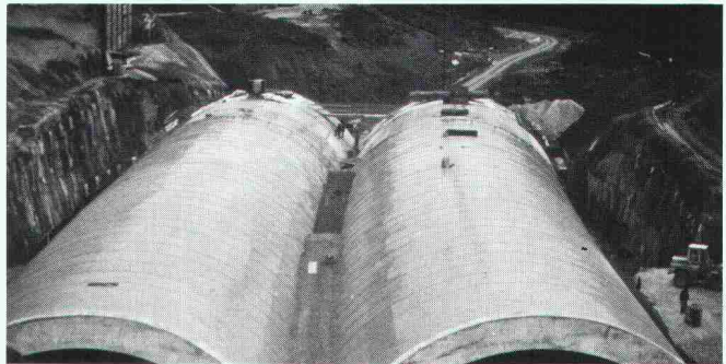
Tunnel Aichelberg, Autobahn A8 Karlsruhe-München, abgedichtet mit 7000 m 2 Sarnafil Typ FP 4 mm.
