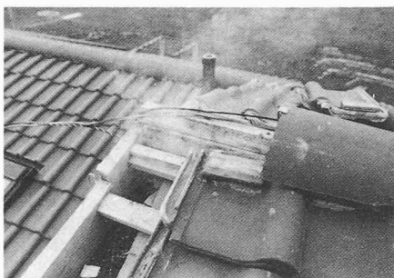
Bild 7. Ortsabschluss mit First. Bei entfernten Ortziegeln klar sichtbarer Rauchaustritt als Folge von Luftundichtigkeiten (Rauchprobe)
