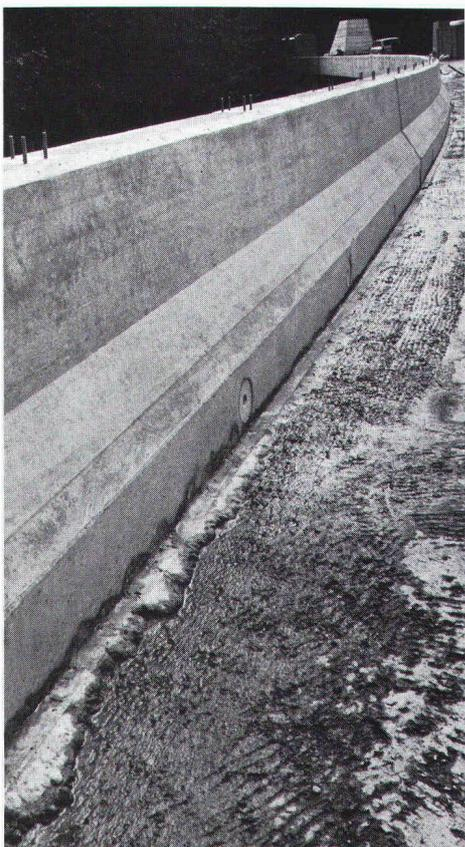
**Bild 4:** Die insgesamt 1136 m<sup>1</sup> Brüstung wurden in 8m-Tagesetappen mittels Schalwagen betoniert. Der engen Radien wegen (R. min. = 190m) konnten die Schalwände für konvexe und konkave Betonoberflächen beliebiger Radien eingestellt werden.
