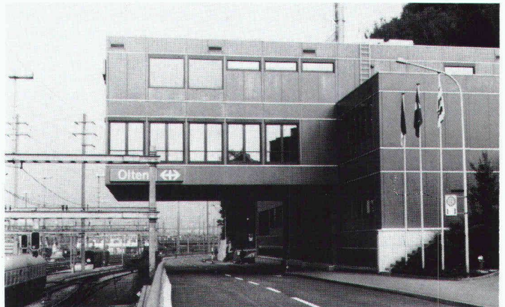
Neues Stellwerk Bahnhof SBB, Olten, Fahrbahnisolierung
