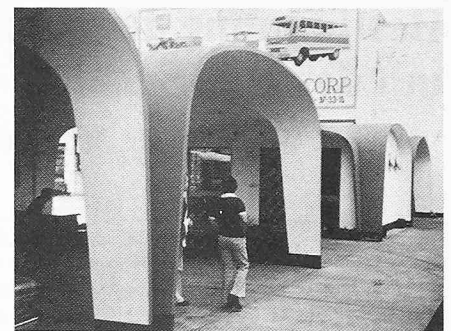
Bild 15. Prototyp Ferrozement-Haus in Manila (Photo: H.D. Sulzer)
