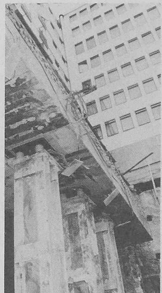
*Enerpac Zylinder der Abfangkonstruktion Brücke Steinstrasse*
