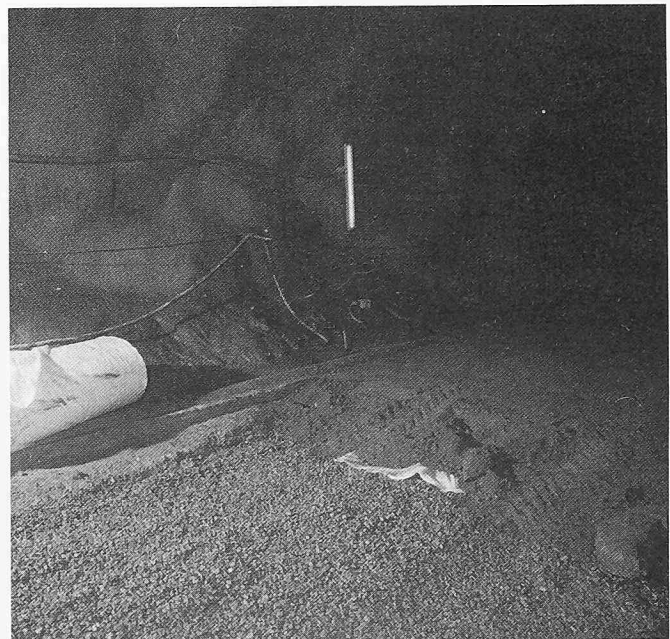
Bild 18. Bahnunterbau. Filterkies und Mitteldrainage. Eingewalztes, zementstabilisiertes Ausbruchsmaterial
