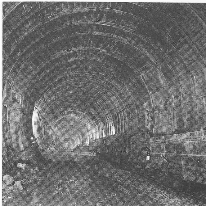
Bild 11. Kreisprofil nach dem Strossenabbau
