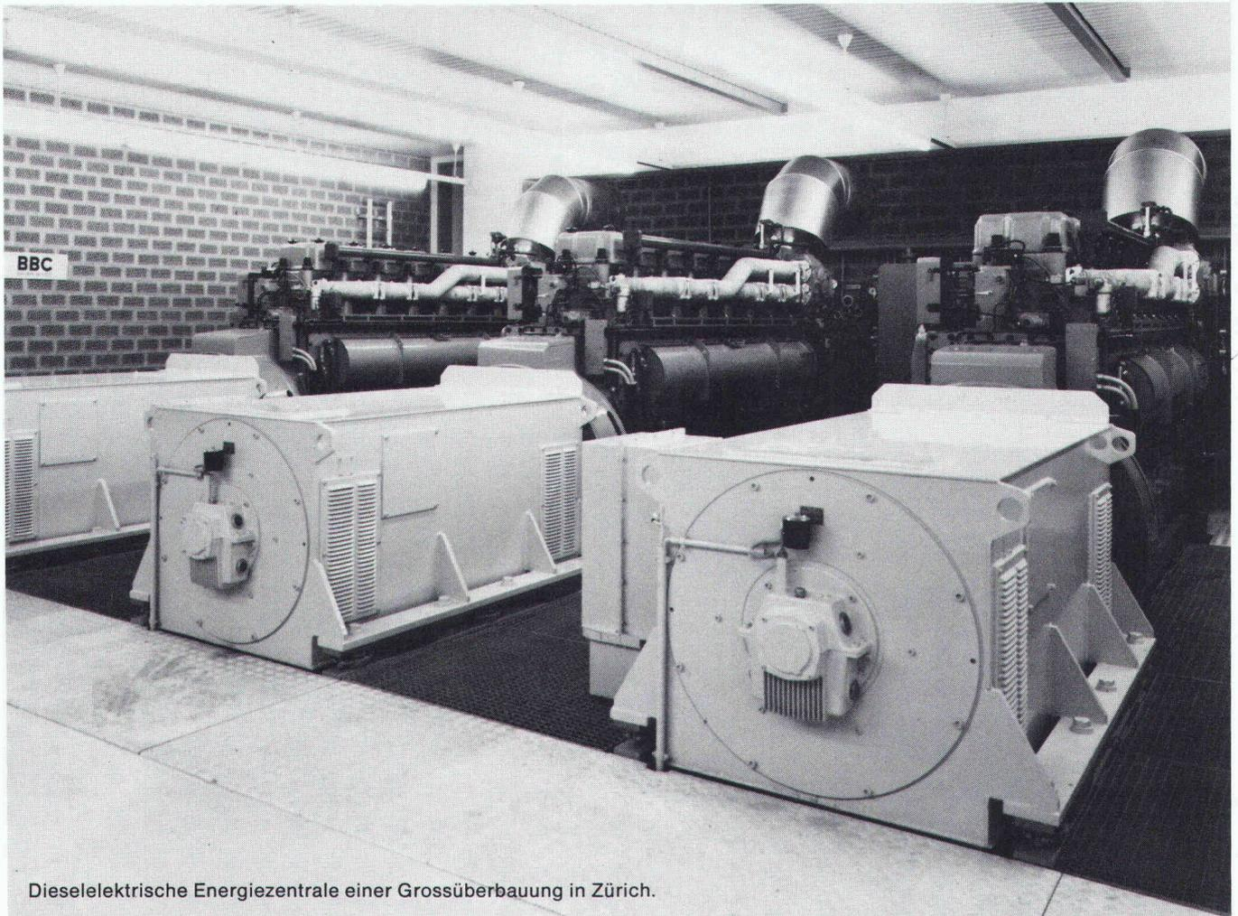
Dieselelektrische Energiezentrale einer Grossüberbauung in Zürich.
