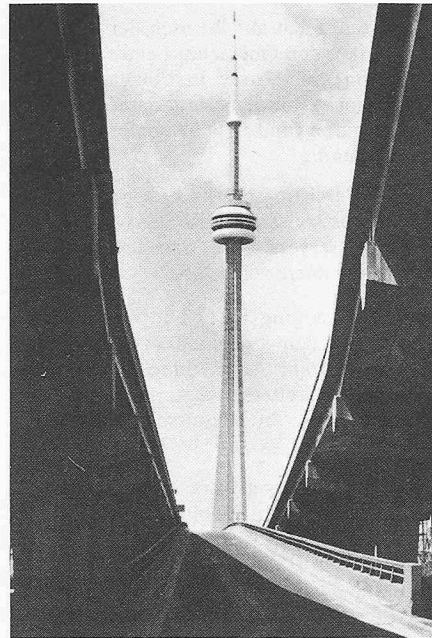
Bild 1. Fernmeldeturm «CN Tower», Toronto (Kanada)
