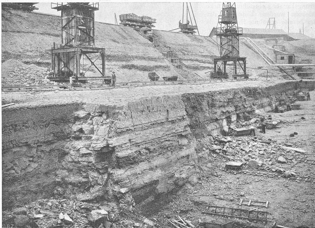
Abb. 3. Baugrube des Maschinenhauses. — Mergelbänke mit darüberliegenden Alluvionen.
