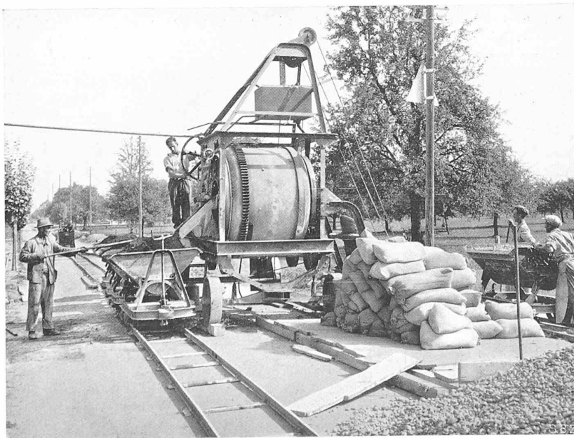
Abb. 3. Freifall-Betonmischer für 500 l Inhalt der stationären Anlage zwischen Arbon und Amriswil. Bauart der v. Rollschens Eisenwerke Rondez (Schweiz).
