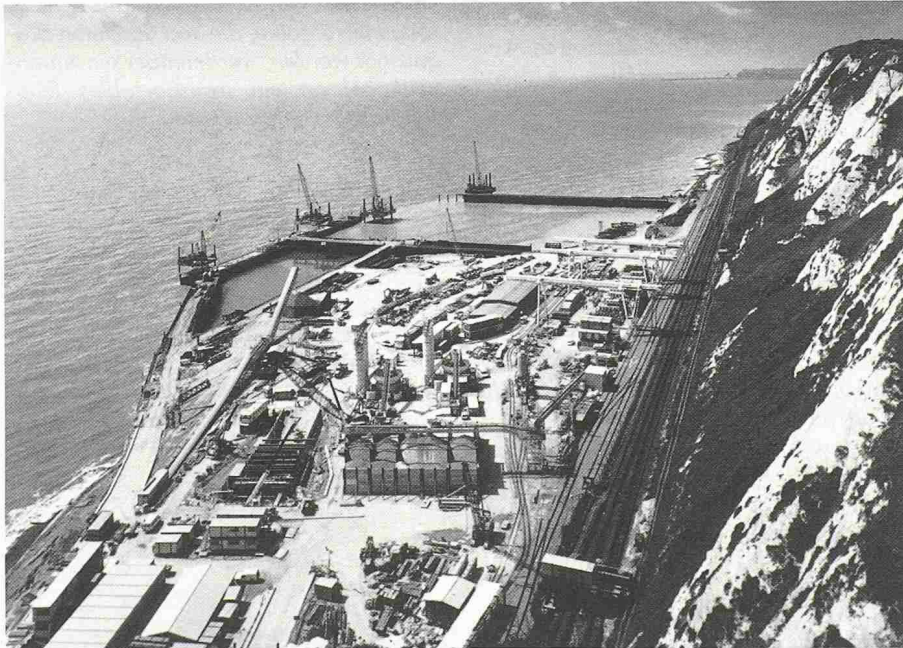
Die Küstenlinie Grossbritanniens wird sich leicht verändern: In der Nähe von Folkestone, Südengland, entstehen neue Strandmauern. Die dahinter liegenden Becken werden mit dem Aushubmaterial des Ärmelkanaltunnels aufgefüllt (Bild: LPS)
