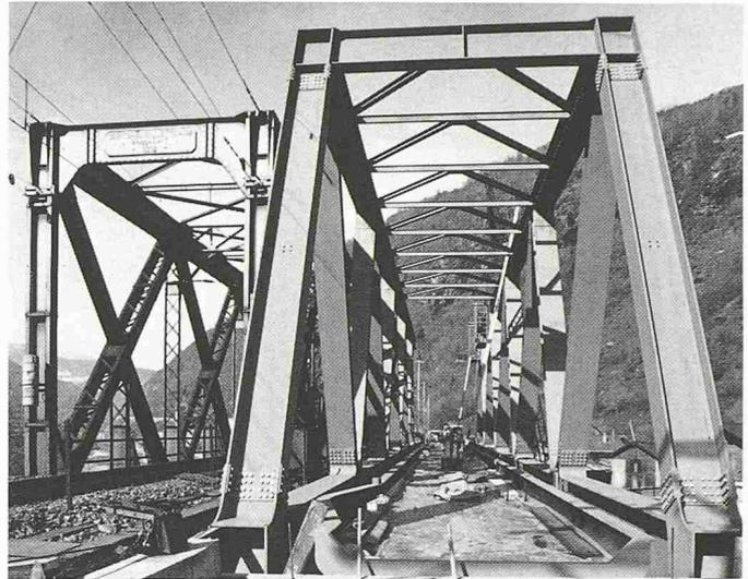
Bild 6. Die alte (links) und die neue Rhonebrücke: die historische Nietkonstruktion mit direkter Schwellenbefestigung neben dem modernen geschweissten, pfostenlosen Dreieckfachwerk in Stahl mit Schottertrog
