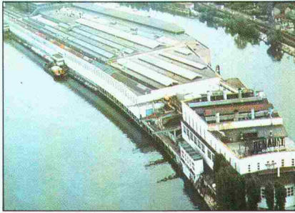
▲ Frankreich : Renault, Boulogne-Billancourt. (Sanierung)
