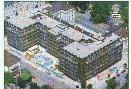
▲ Schweiz : Verwaltungsgebäude, Mythen-schloß, Zürich.
