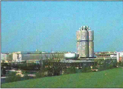
▲ Deutschland : BMW-Verwaltungsgebäude, München, über 300.000 m 2 FOAMGLAS® wurden bei BMW eingesetzt.
