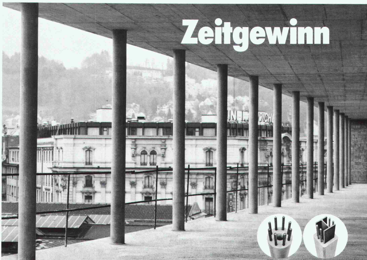
Neubau Bahnhof Luzern
