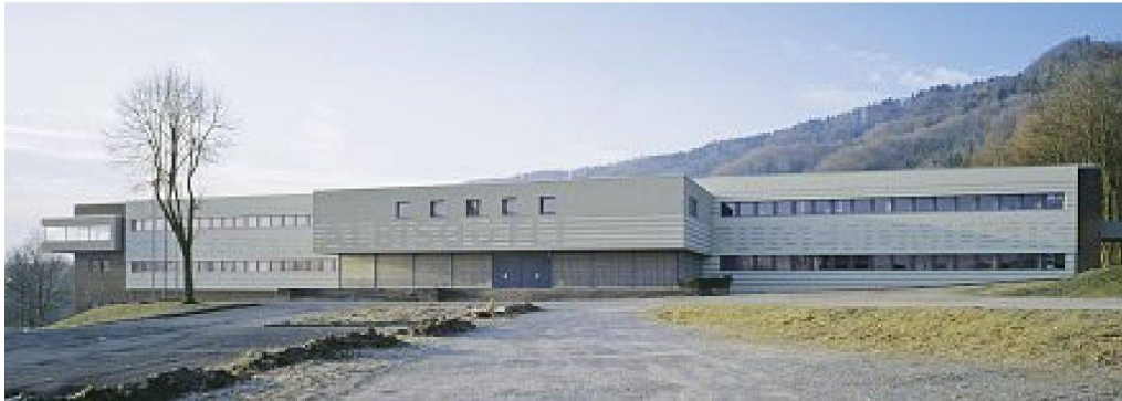
Nordfassade mit dem Schriftzug in Form eines kommunikativen Ornaments (links oben), offene Südfront zu den Zielscheiben (links unten), neuer Musiksaal im OG (rechts oben) und Schiessstand im EG (rechts unten)
